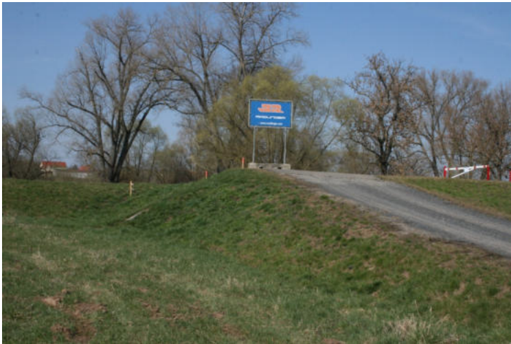
Blick von der Mühle Ostrau Richtung saniertem Deich. (22.03.2026)
