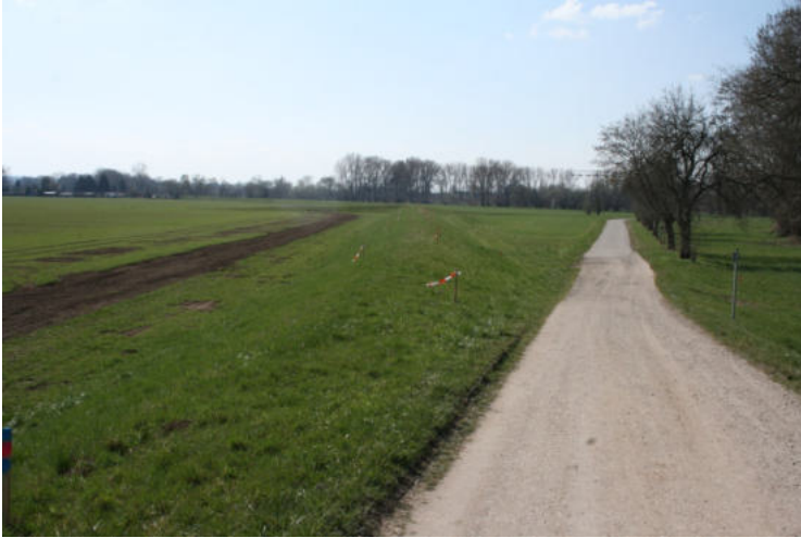
Blick aus Ostrau Richtung Göbitz auf der Deichüberfahrt (22.03.2026)
